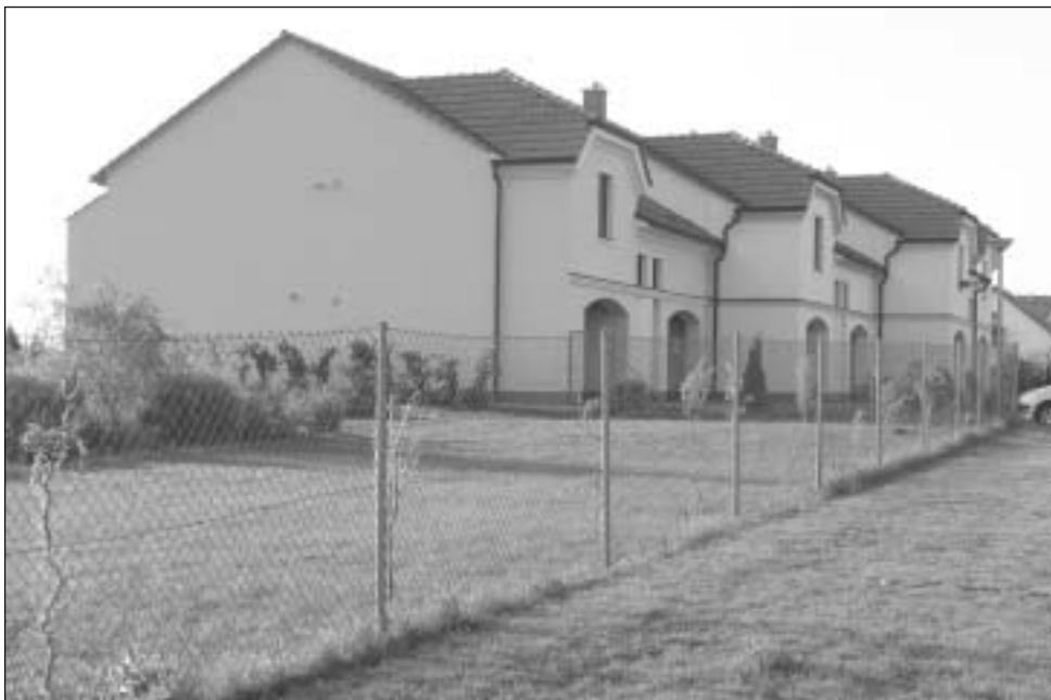
Bytový blok E na ulici Rozprýmově
